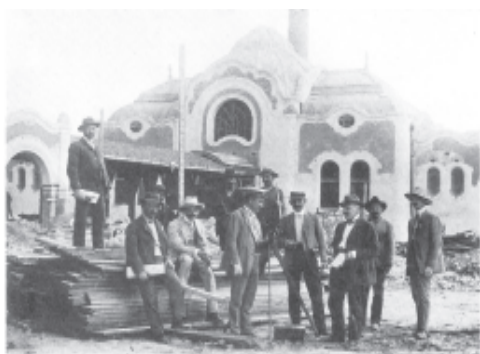
A vizaknai gyógyfürdő építése Alsó-Fehér vármegye (1910 körül)
